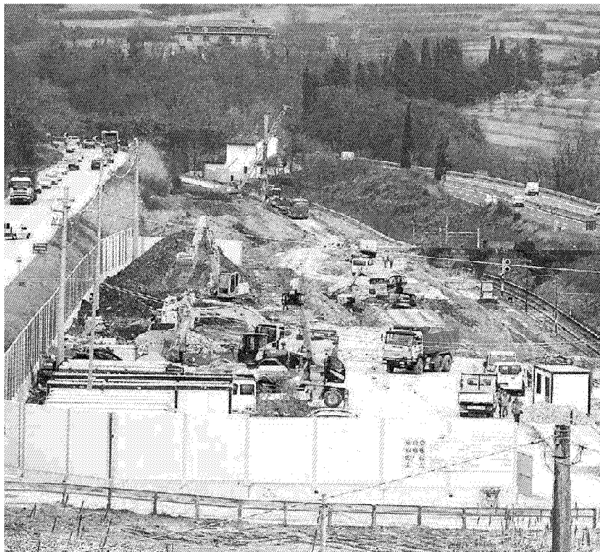
Il cantiere base a fianco della Lucchese dove si lavora al raddoppio ferroviario (foto Gori)
