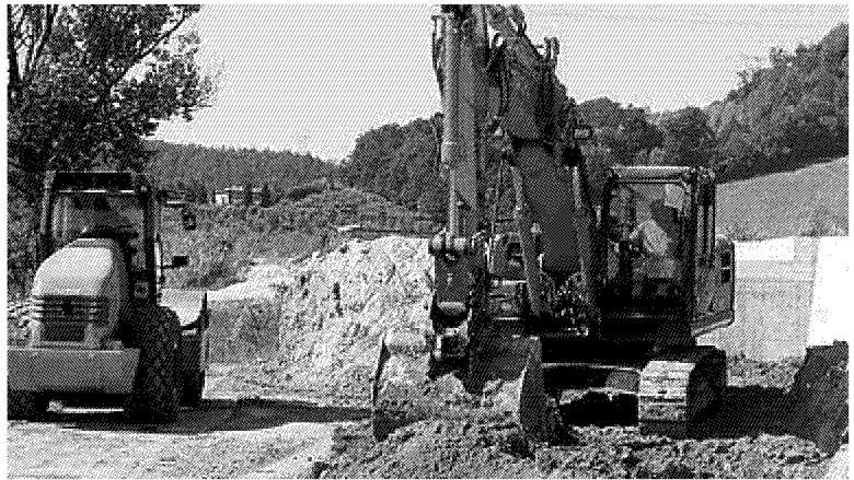
Ruspe al lavoro sul tracciato della 429, il cantiere 'infinito' del territorio dell'Empolese Valdelsa
