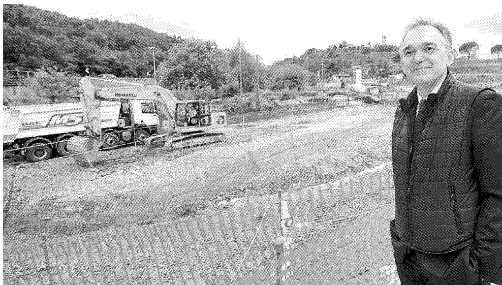
Enrico Rossi all'inaugurazione del cantiere per il raddoppio della linea ferroviaria Pistoia-Lucca
