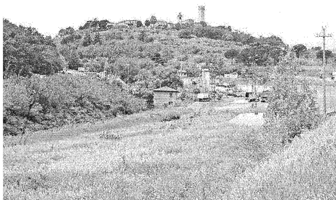
Il cantiere per il raddoppio della ferrovia sulla linea Pistoia-Lucca
