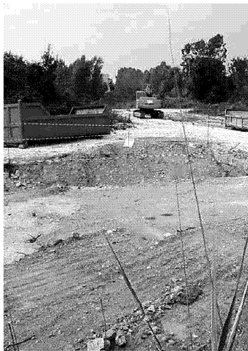
La rimozione delle terre nell'area ex Farmoplant vicino a via degli Unni e una ruspa al lavoro
