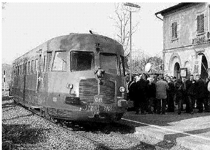
L'inaugurazione della linea Cecina-Volterra
