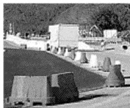
Uno dei cantieri sulla Grosseto-Siena
