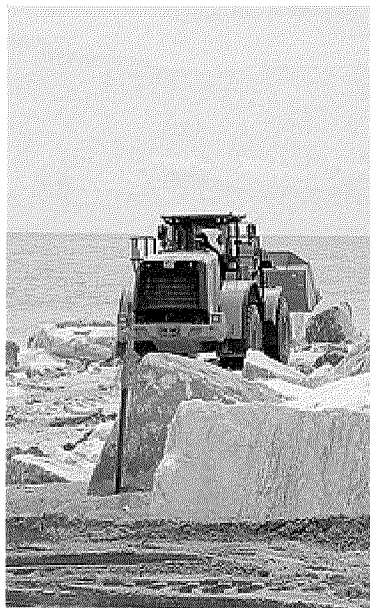
ALL'OPERA Una ruspa sistema i blocchi per realizzare una scogliera contro l'erosione
