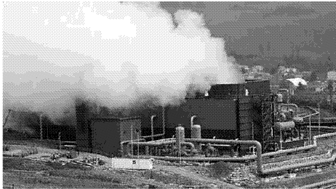
Una centrale geotermica
