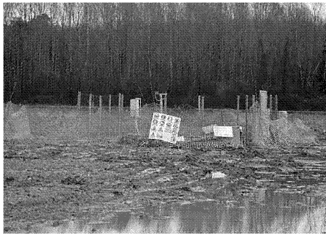
Il cantiere per la costruzione della nuova antenna
