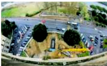
Un'immagine aerea del cisternone
