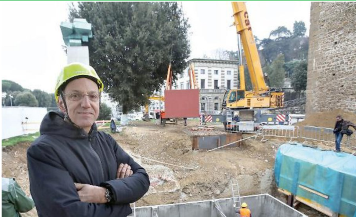
La posa delle grandi cisterne per alimentare le fontane a Porta San Niccolò
