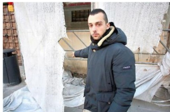
E' fermo da tempo il cantiere del Palazzo Pretorio di piazza Ginori. Ora il Comune spera di farlo ripartire entro la primavera
