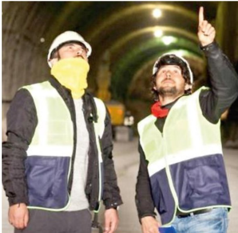
RILIEVI Alcuni operai durante i lavori all'interno di una galleria
