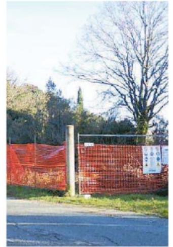
L'AREA È STATA DELIMITATA PER COMINCIARE I LAVORI DELLA NUOVA STRUTTURA
