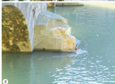
Nella foto numero 1 lo smottamento lungo la Statale del Brennero dopo il nubifragio di sabato che ha costretto Anas alla chiusura in prossimità del bivio per Corsagna Nella foto 2 il dettaglio del "contrafforte" del Ponte del Diavolo danneggiato dalla piena del Serchio. Nella foto numero 3 una panoramica del Ponte dalla quale è evidente il danno
