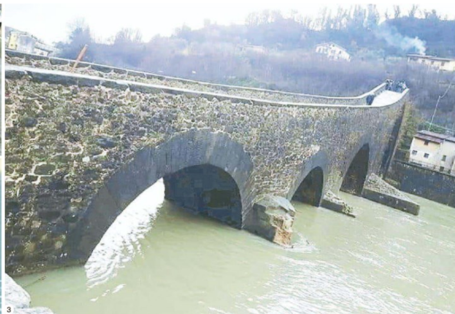
Nella foto numero 1 lo smottamento lungo la Statale del Brennero dopo il nubifragio di sabato che ha costretto Anas alla chiusura in prossimità del bivio per Corsagna Nella foto 2 il dettaglio del "contrafforte" del Ponte del Diavolo danneggiato dalla piena del Serchio. Nella foto numero 3 una panoramica del Ponte dalla quale è evidente il danno
