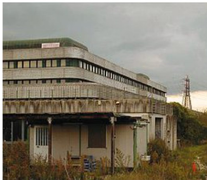
Il «Palazzaccio» a Scandicci, costruito nel '94. Doveva essere il centro operativo per l'Agenzia delle entrate, l'arrivo dei computer l'ha reso inutile
