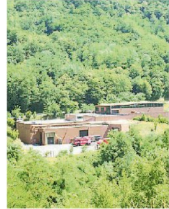
L'impianto di Tana Termini
