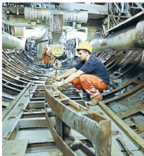
Al lavoro sul cantiere del tunnel geognostico della Maddalena a Chiomonte, in Val di Susa
