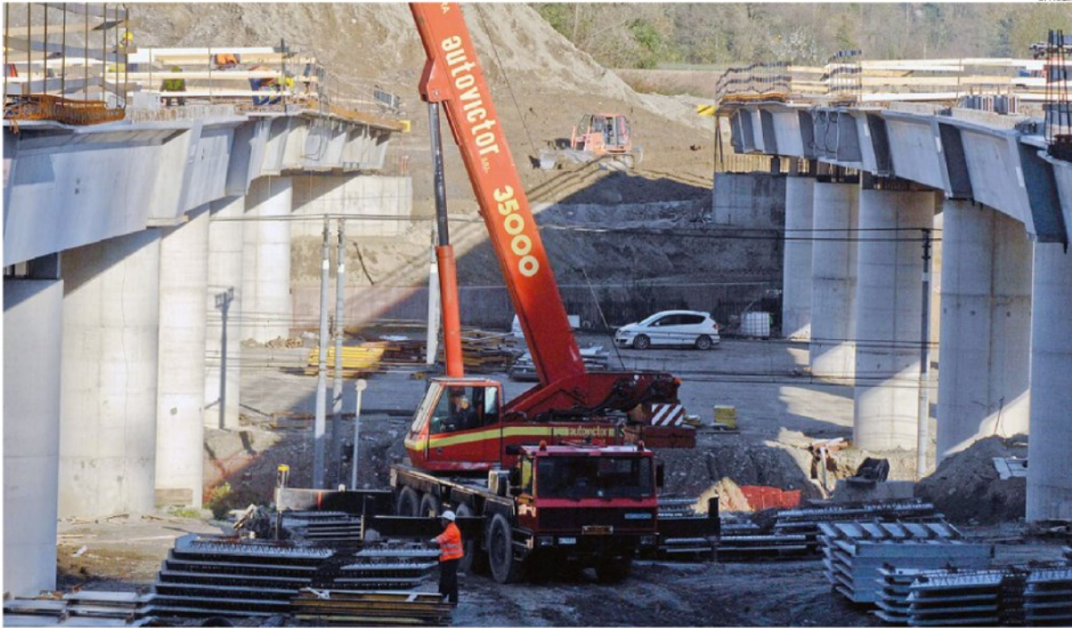
Pedemontana. Cantieri sulla autostrada Pedemontana Lombarda. La grande opera ha l'obiettivo di velocizzare gli spostamenti nell'area nord di Milano, per collegare Varese con Bergamo
