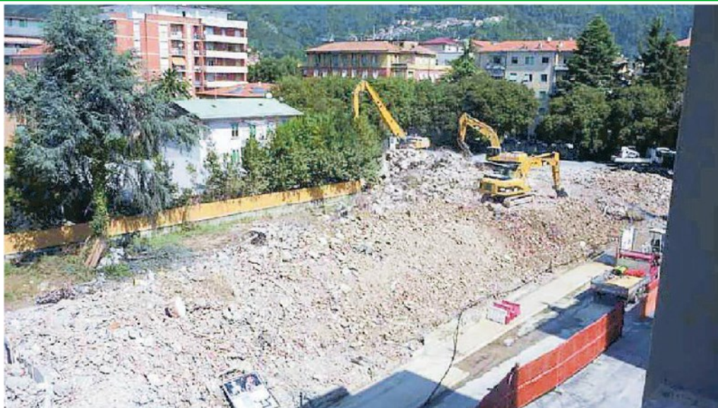
Una foto d'epoca: l'area della ex Intendenza di Finanza subito dopo la demolizione dell'immobile
