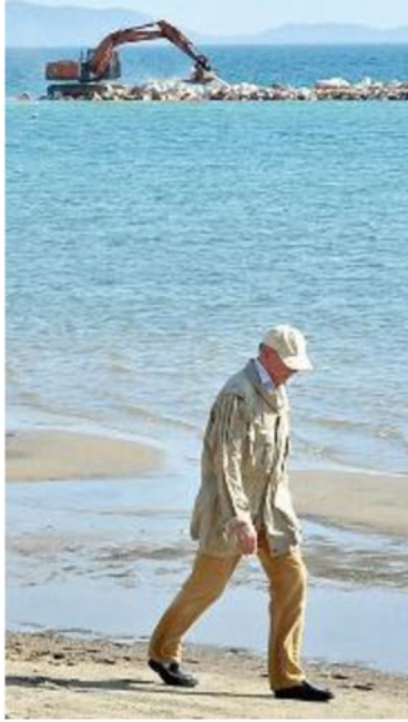
LAVORI Molte spiagge necessitano di ripascimento
