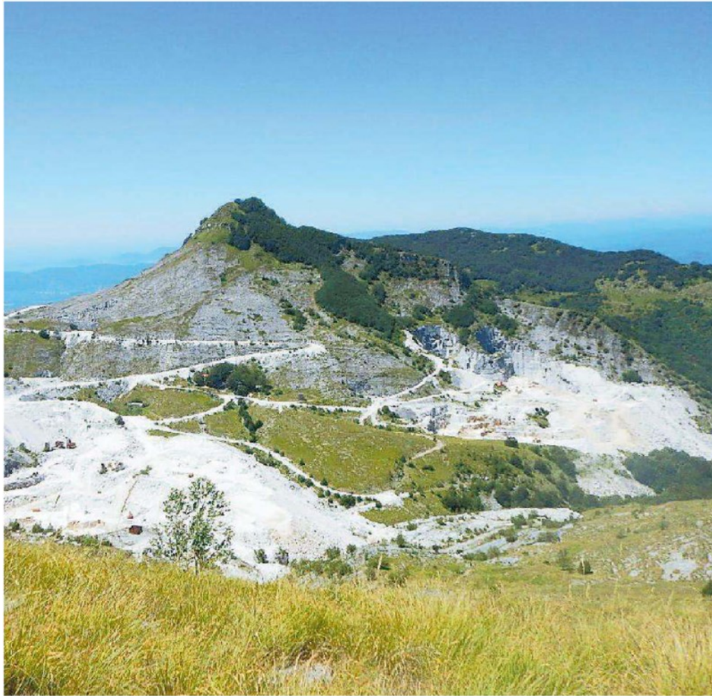
La cava di Castelbaito Fratteta (a destra) alle pendici del monte Borla
