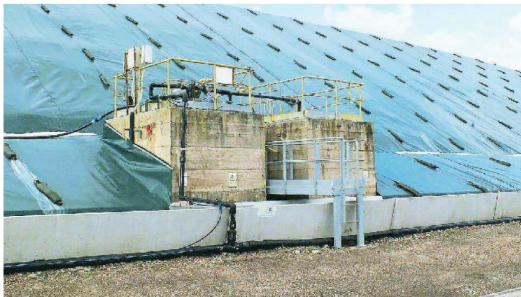
Impianti di Rimateria alla base della discarica di Ischia di Crociano (foto Pabar)
