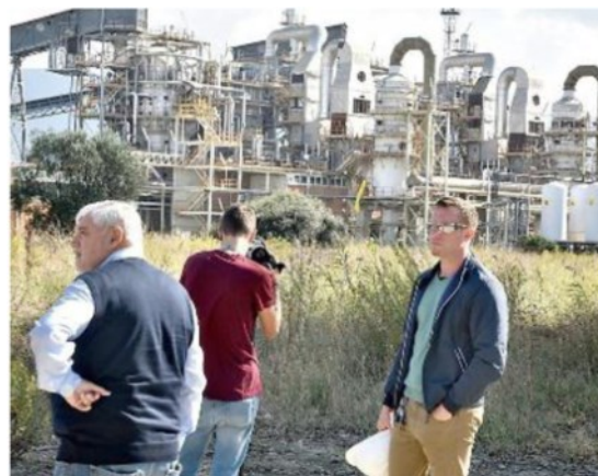
L'IMPIANTO DELLA DISCORDIA Il termovalorizzatore di Scarlino, spento forse in maniera definitiva dal Consiglio di Stato
