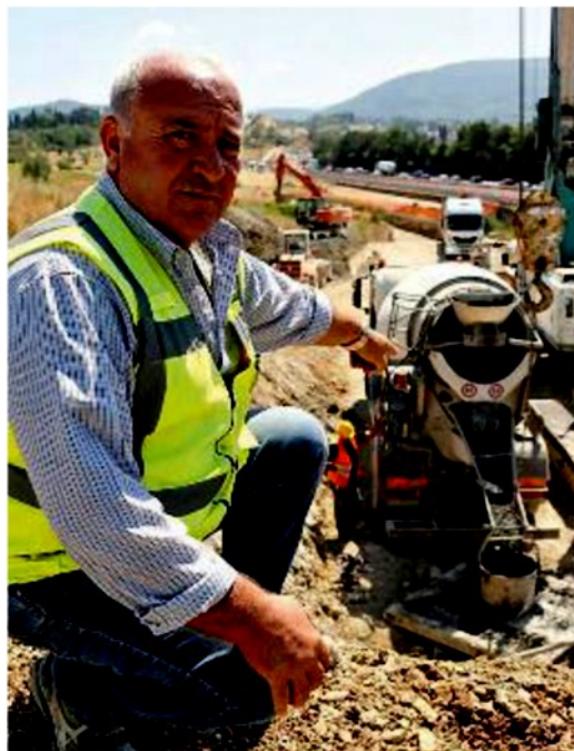
LAVORI I cantieri per la terza corsia sull'A1
