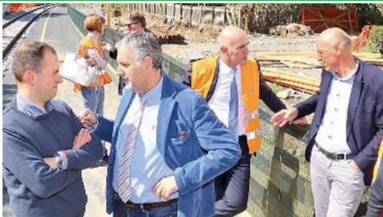
Il vice presidente Daniele Matteini e un sopralluogo al cantiere
