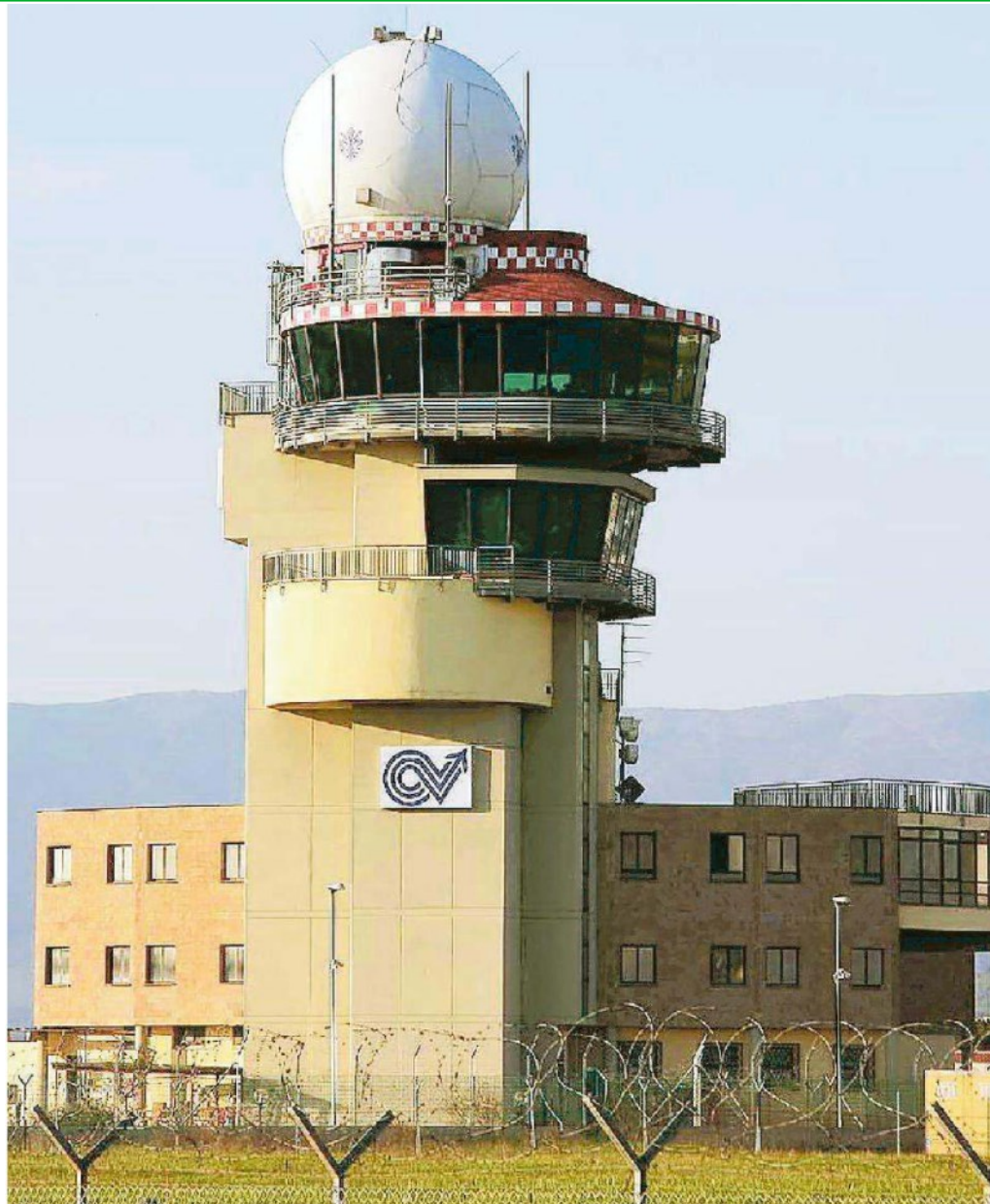
La torre di controllo dell'aeroporto di Firenze
