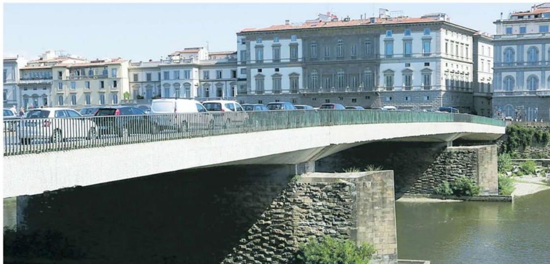
Ponte Vespucci Partono i lavori di messa in sicurezza di uno dei piloni
