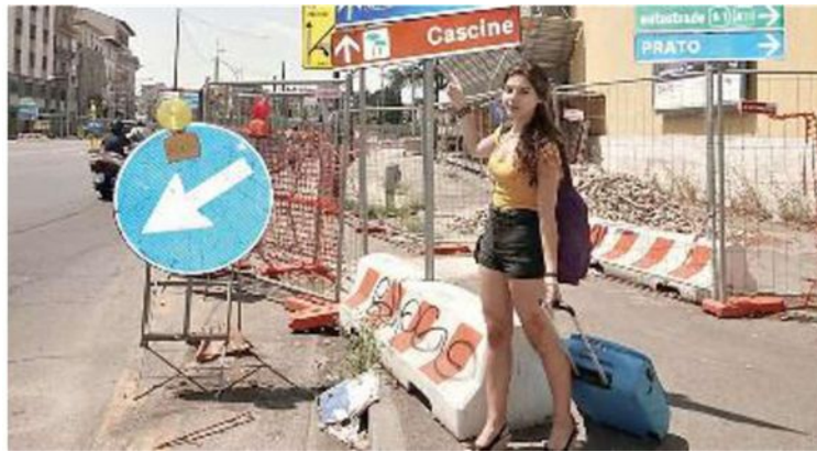
Oggi dovrebbero riprendere i lavori nei cantieri della Linea 2. La speranza è di poterli ultimare entro l'autunno
