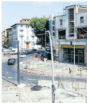
Palazzo Mazzonis Il cantiere della linea 2 attraversa il palazzo Mazzonis a Belfiore
