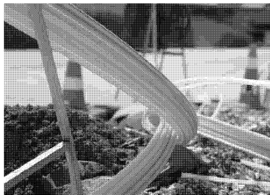
Lavori per la posa di cavi in fibra ottica
