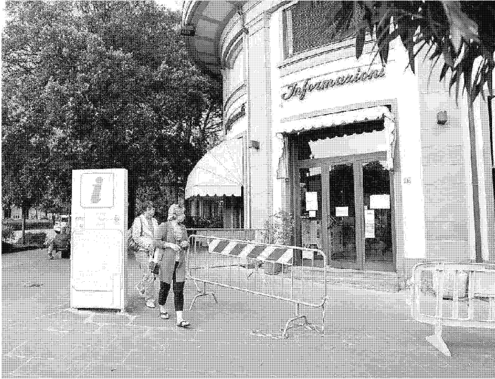
Le transenne sistemate davanti all'ex Apt a causa del crollo di pezzi di cornicione (Foto Nucci)
