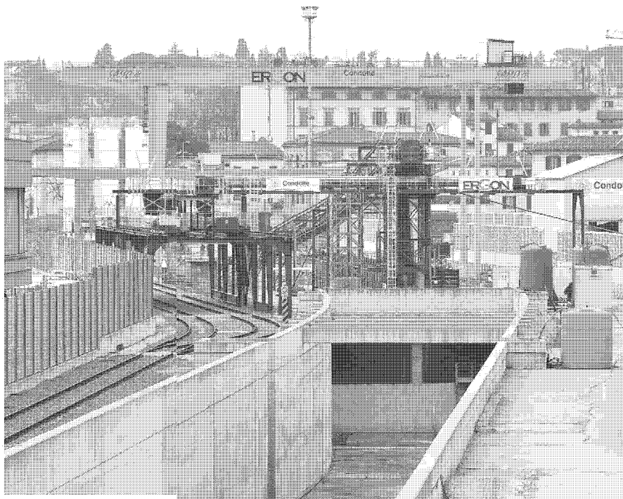
Gli scavi Campo di Marte per costruire il tunnel sotterraneo dell'Alta velocità: il cantiere è rimasto fermo a lungo in attesa di capire come debbano essere smaltiti i detriti.
