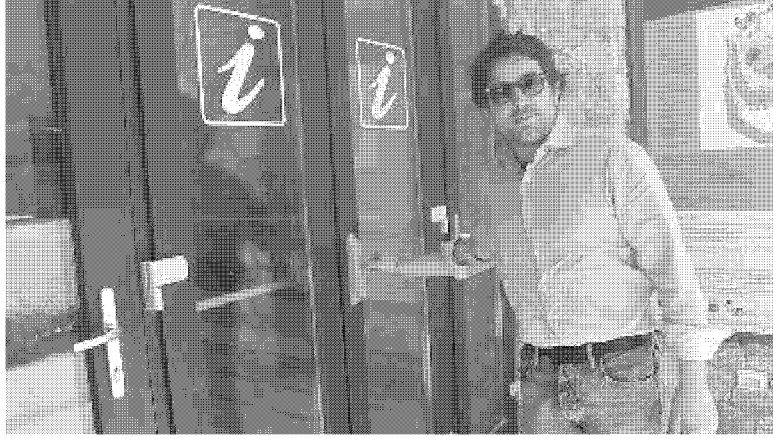
DEGRADO Porte chiuse e soldi spesi per niente a Fossacava
