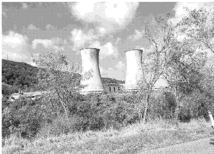
Torri refrigeranti degli impianti geotermici a Larderello
