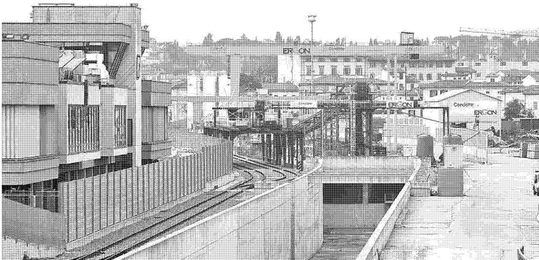
Il cantiere Lo scavo della Tav a Campo di Marte
