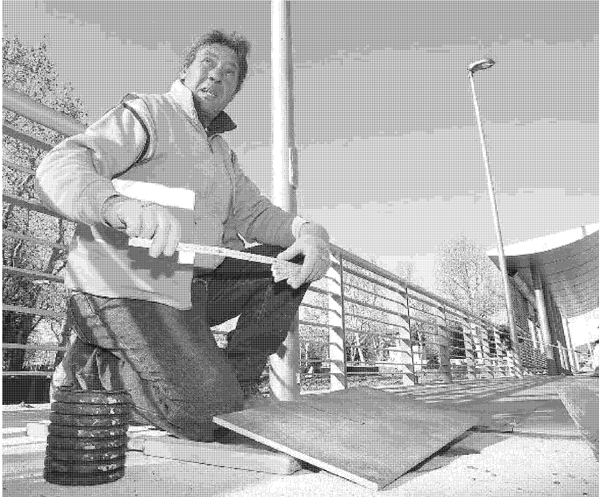
Come ogni lunedì, si spostano i cantieri delle due linee di tramvie con nuove disposizioni per il traffico
