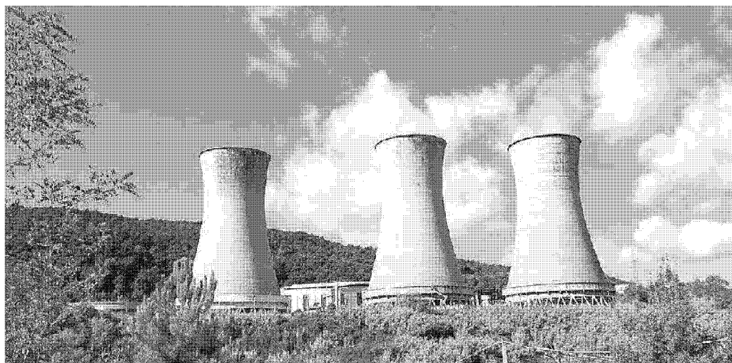
Impianti geotermico a Larderello (Foto d'archivio)
