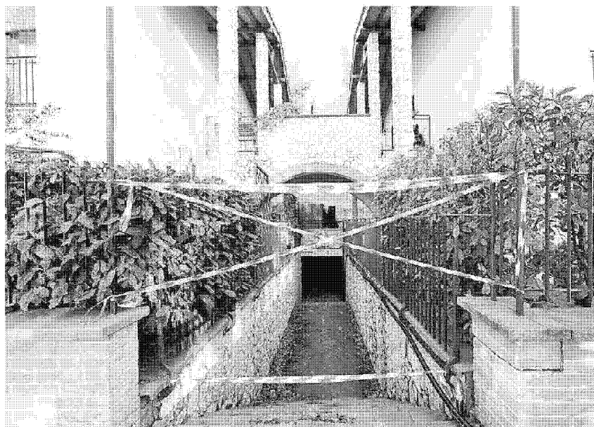
Una zona del complesso edilizio interdetta al passaggio
