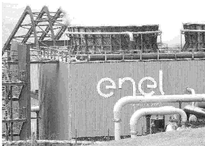
Una delle centrali di Enel Green Power
