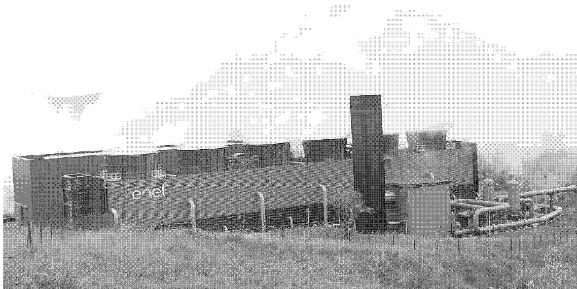
La centrale geotermica di Bagnore
