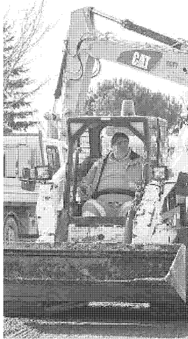
I lavori in corso anche ieri sul cantiere: finiranno a ottobre
