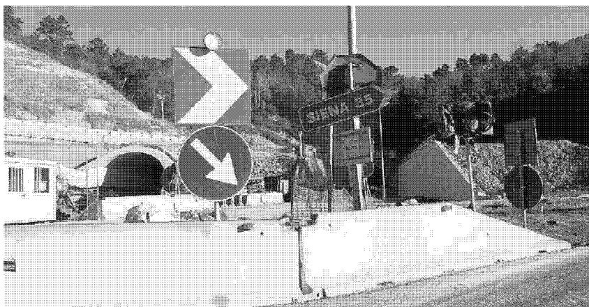
Lavori in corso sulla Statale 223 all'altezza della galleria di Pari (foto Agenzia Bf)
