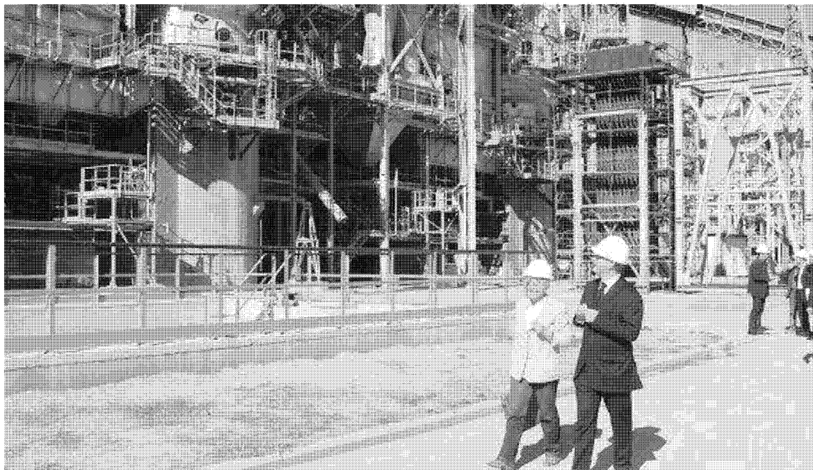
COGENERATORE L'impianto di Scarlino durante una delle numerose visite (Foto Agostini)
