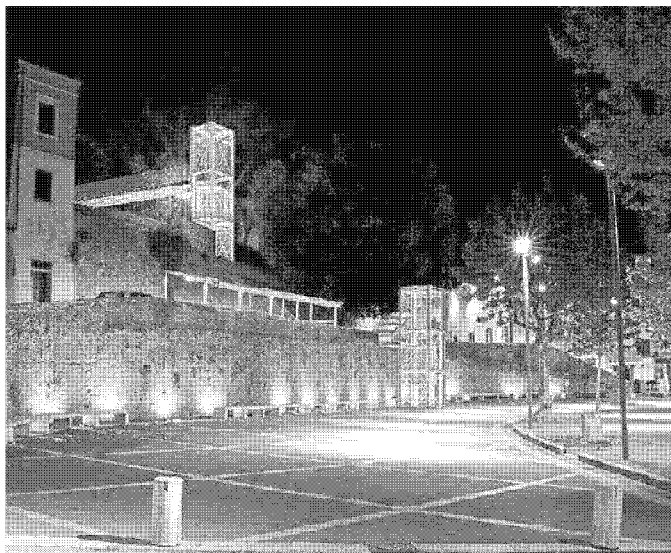
Il rendering del doppio ascensore che collegherà piazza del Popolo e via Tilli
