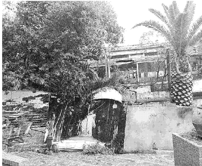
La facciata dell'ex Ciucheba
