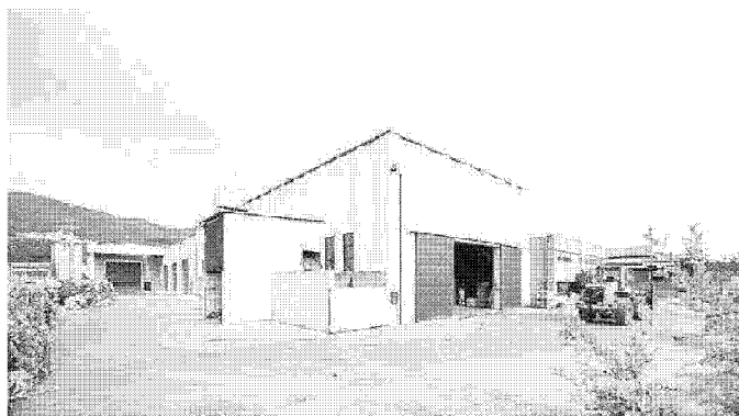
L'impianto di trattamento rifiuti "Costa" di Albiano Magra
