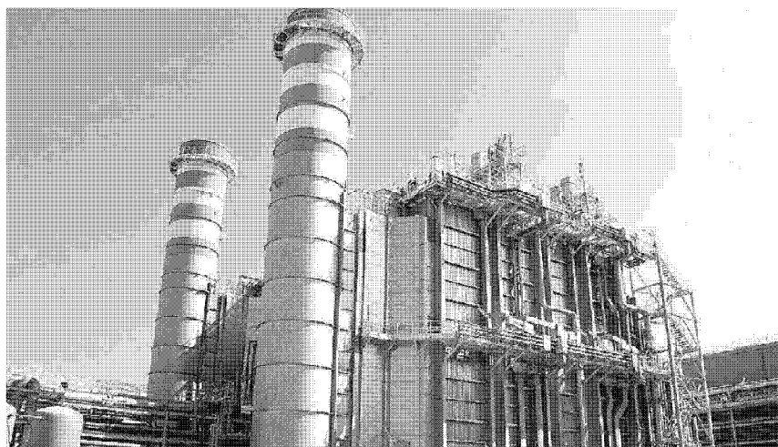
La centrale turbogas di Rosignano è interessata da un progetto di riqualificazione
