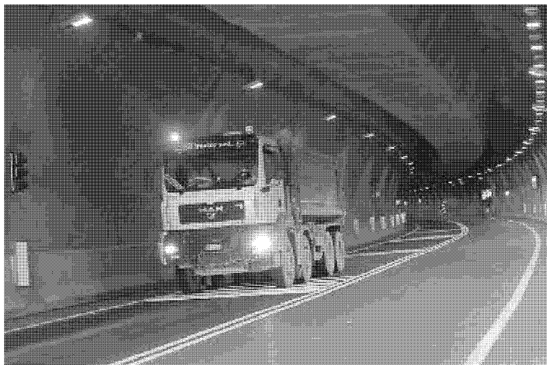
GALLERIA La strada dei marmi non sarà più solo a beneficio dei camion ma potranno percorrerla anche le auto e le moto
