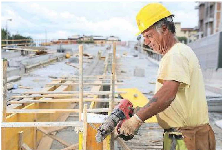
Continuano i lavori all'interno del cantiere della tramvia
